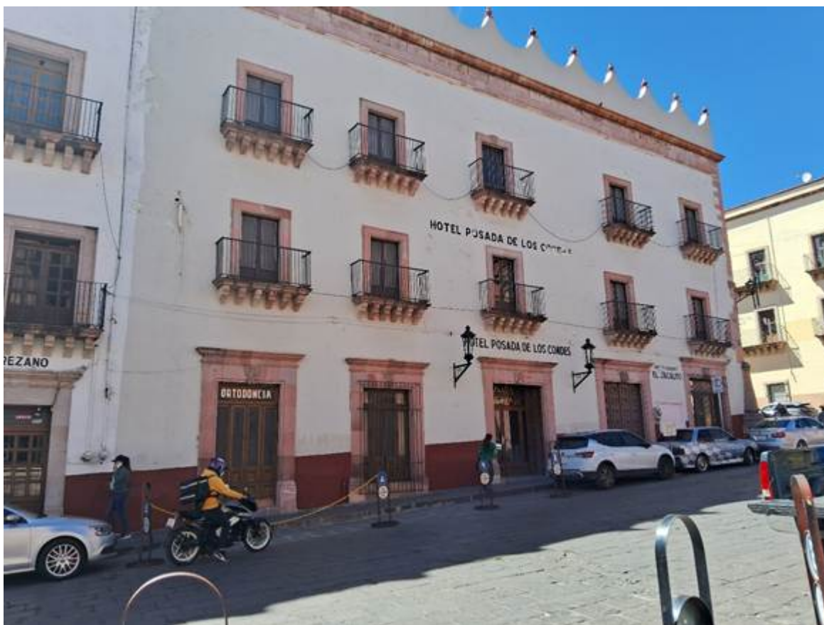
Casa de la Condesa en la actualidad (Foto propia).
